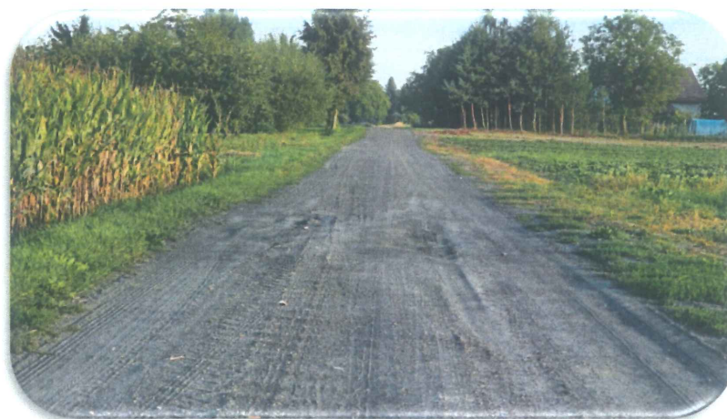
Fot. 5. Widoczne nierówności nawierzchni.
